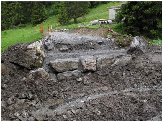
*Das auf der Westseite gelegene Brücken-Widerlager konnte bereits fertiggestellt werden. Verwendet wurden grosse Steinblöcke, Beton wird möglichst sparsam verwendet.*
