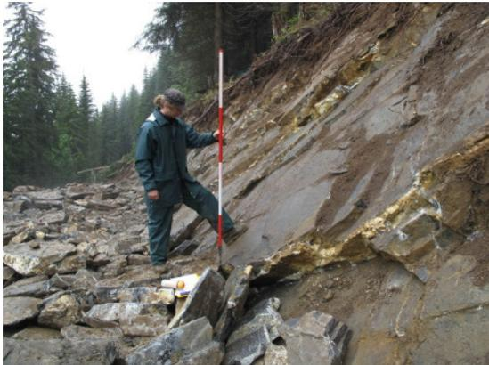
*Teilweise instabile Platten an der bergseitigen Böschung im Schwandwald.*
