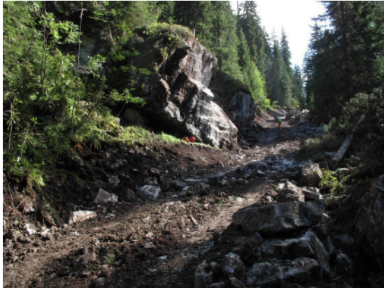
Einbettung ins Gelände: Ausholzung einer möglichst schmalen Wegschneise und Umfahren grösserer Blöcke.
