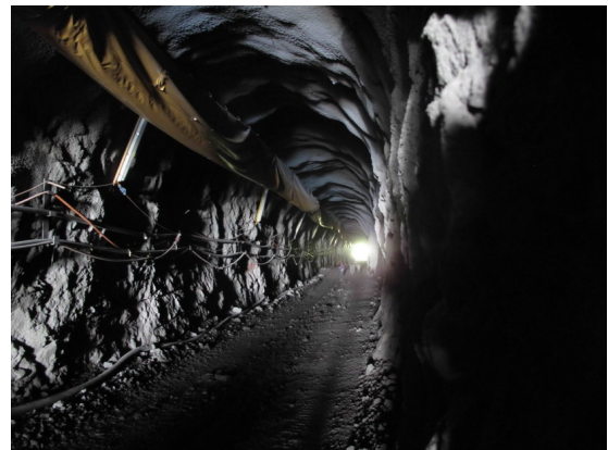
Endlich da: Das lang ersehnte Licht am Ende des Tunnels. (Photo Ch. Lüthi)
