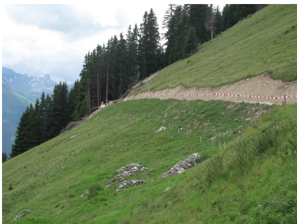
Noch sind die berg- und talseitige Böschung unterschiedlich grün. (Photo Ch. Lüthi)
