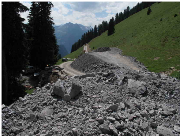
Auf zwei Halden warten rund 8'000 m 3 Gesteinsmaterial auf die Weiterverarbeitung. (Photo Ch. Lüthi)
