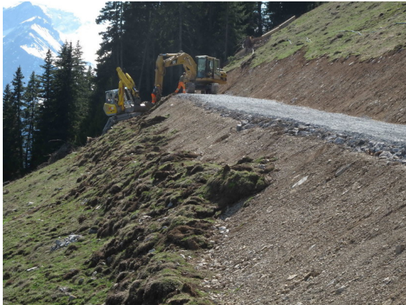
Die bereits erstellte Baupiste als Zufahrt zum Tunnelportal Ost. (Photo Ch. Lüthi)
